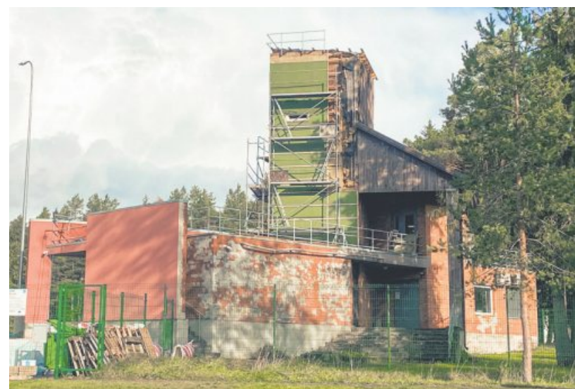
Käsil on Kehtna staadionimaja torni remont.
