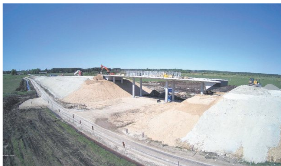
Kehtna–Põlma maanteeviadukti ehitus.
