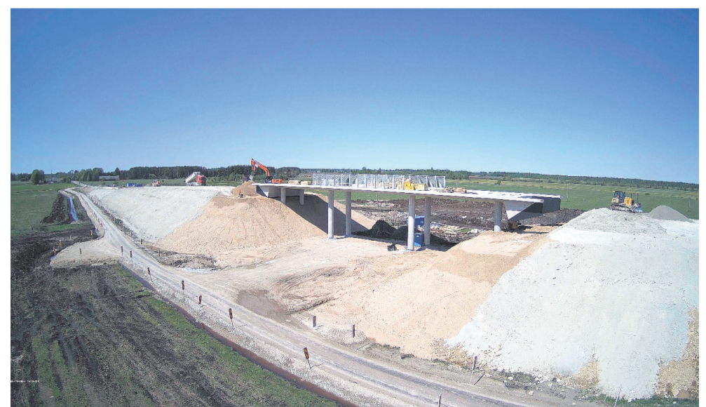
Kehtna–Põlma maanteeviadukti ehitus.
